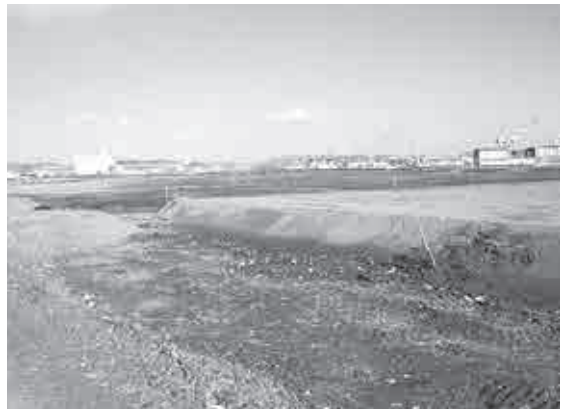
かさ上げ盛土工事
